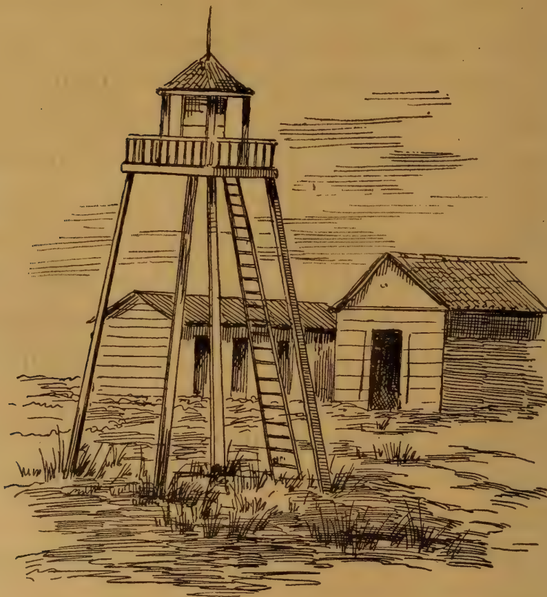
CASA TORRE DE LOS PRACTICOS (Matanzas)
